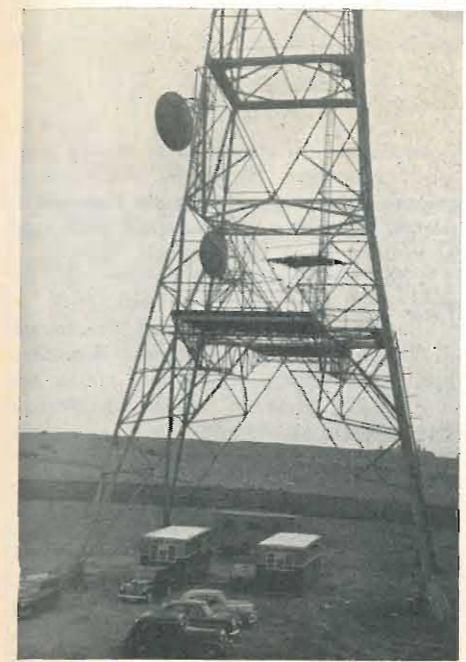
Ecco le antenne del ponte radio a 2000 MHz a Swingate in Inghilterra
